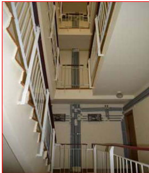
Fig. 7.b – Variantă de amplasare a sistemului de distribuție pe orizontală cu trecere prin planșee
